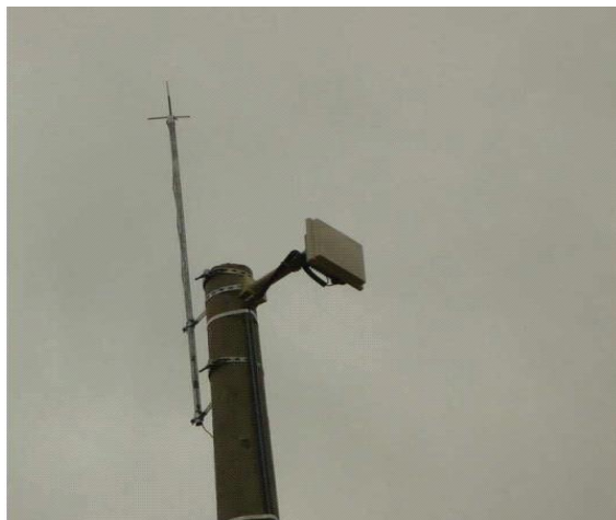
Figura 15: Sistema de fixação suporte radio
